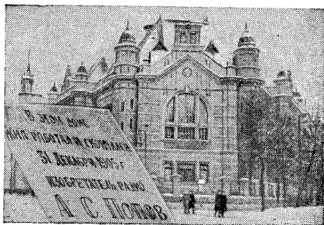
Здание Ленинградского электротехнического института, первым выборным директором которого в 1905 г. был А. С. Попов
